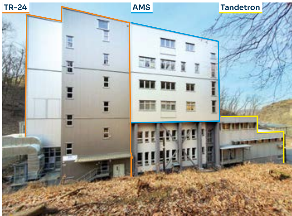
▪ Obr. 2: Objekt 231 ÚJF AV ČR zahrnující prostory Laboratoře Tandetronu, věže cyklotronu TR-24 a Laboratoře AMS. Selektivně jsou upraveny barvy a doplněna kontura pro odlišení částí objektu. Foto: J. Kameník
