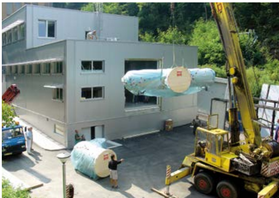
▪ Obr. 2: Obrázek ze stavby haly a stěhování urychlovače. Foto: Archiv ONIM
