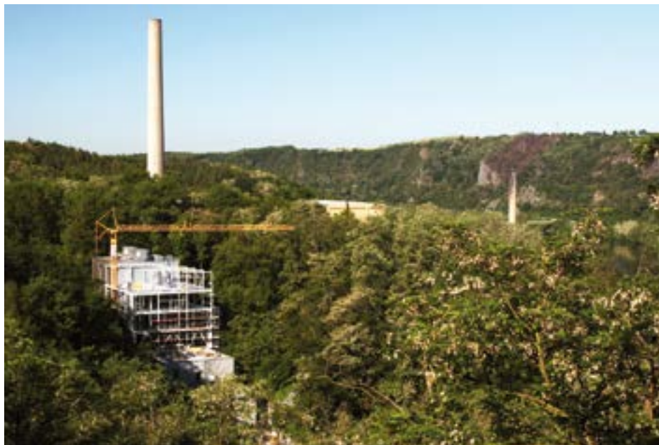
■ Obr. 1: Budování nástavby objektu 231 pro laboratoř AMS. Foto: J. Kameník
