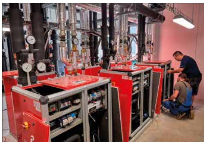
Obr. 5 Strojovna, s pokročilým ekologickým řešením klimatizace a vytápěním budovy, zabírá celé jedno patro a využívá rekuperace odpadního tepla ze zařízení MILEA
