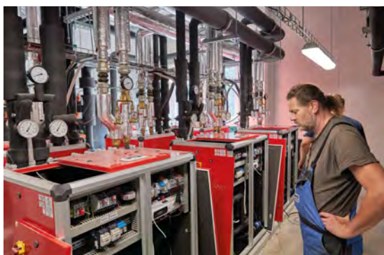
Strojovna budovy AMS laboratoře využije i rekuperace odpadního tepla ze zařízení MILEA. Foto: ÚJF AV ČR
