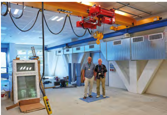
Hala pro zařízení MILEA krátce před kolaudací. Foto: ÚJF AV ČR
