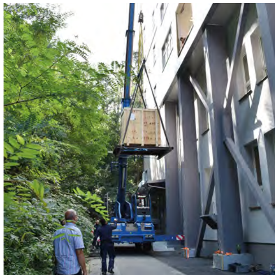
Stěhování beden se zařízením MILEA do 3. patra budovy musel obstat jeřáb. Foto: ÚJF AV ČR
